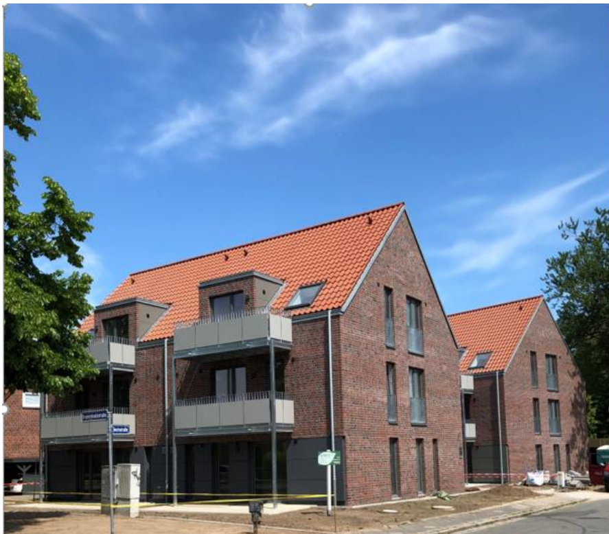
Aktueller Bautenstand der Siedlungs-Häuser Nr. 6 und 7
